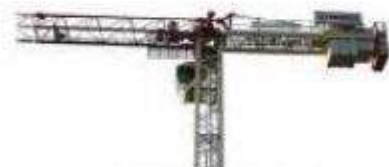
GRU A TORRE
